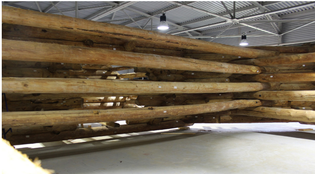
Рис. 11. Четвериковые балки
