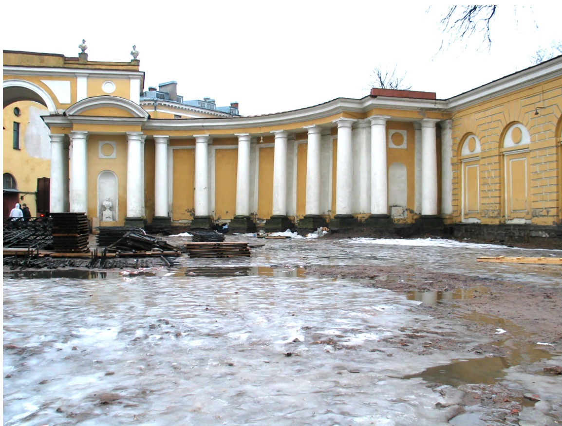
Рис. 2. Парадный двор и каменная ограда до начала реставрации. 2005 г.
