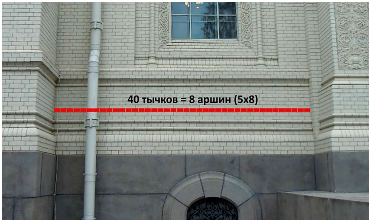
Рис. 2. Фрагмент стены между контрфорсом и входным порталом боковым фасада
