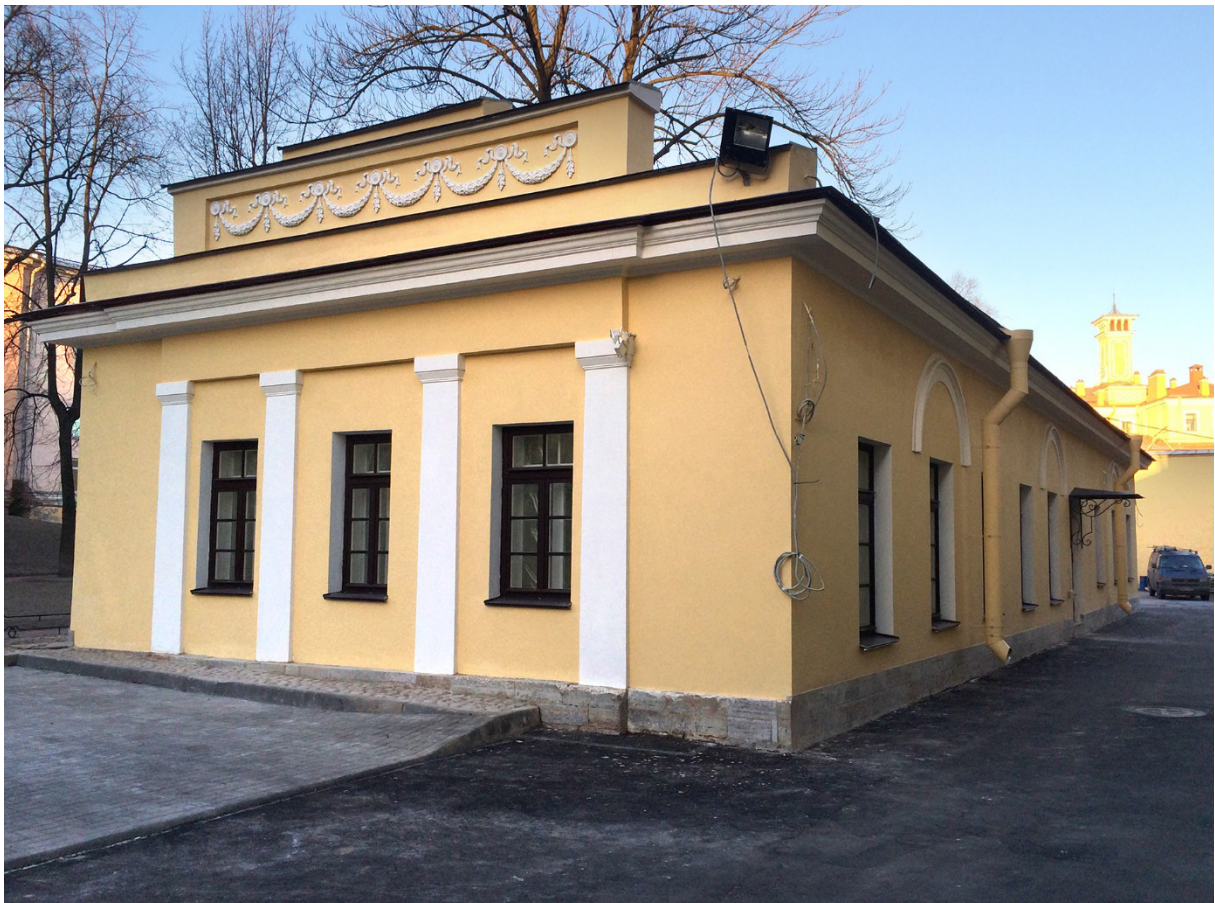
Рис. 5. Прачечный флигель после выполнения работ. 2015 г.
