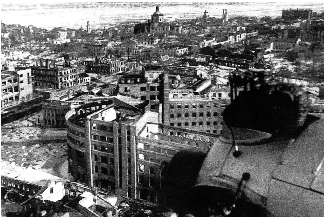
Рис. 1. Вид с самолета на разрушенный центр города Воронежа
