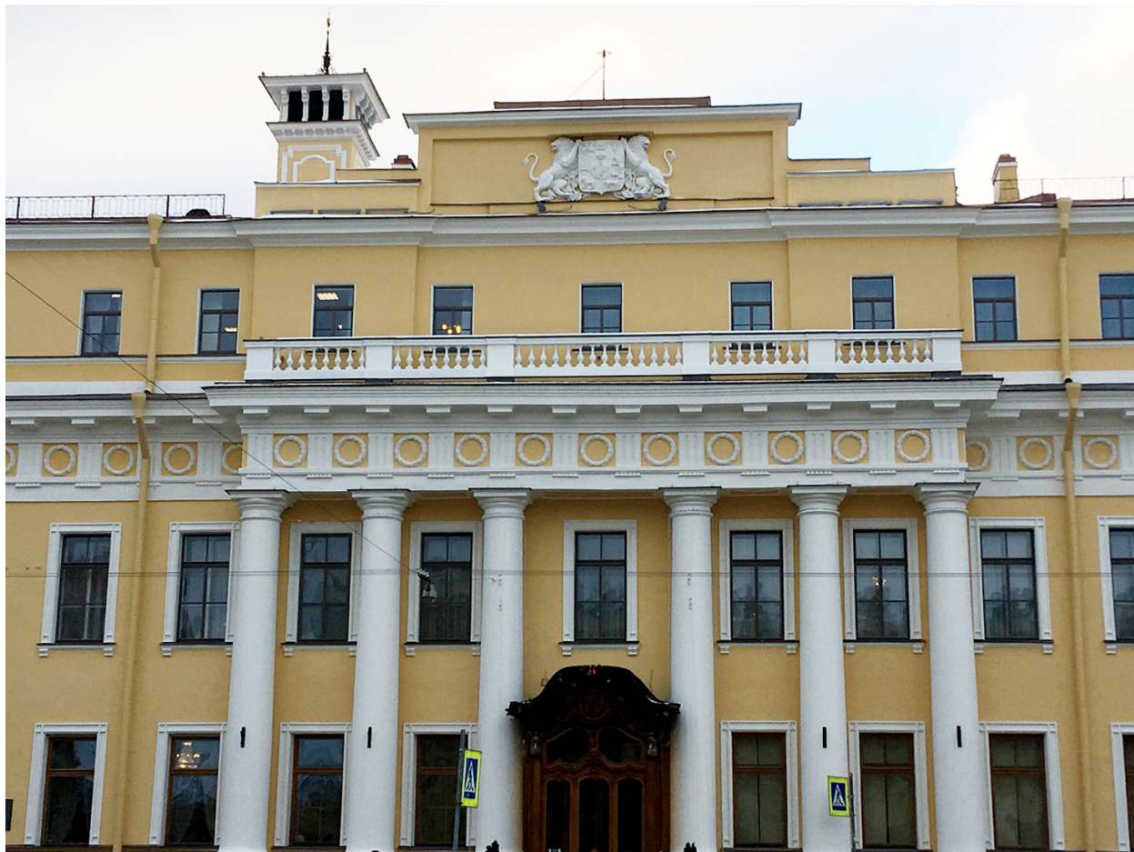
Рис. 7. Главный фасад после проведения работ. 2017 г.
