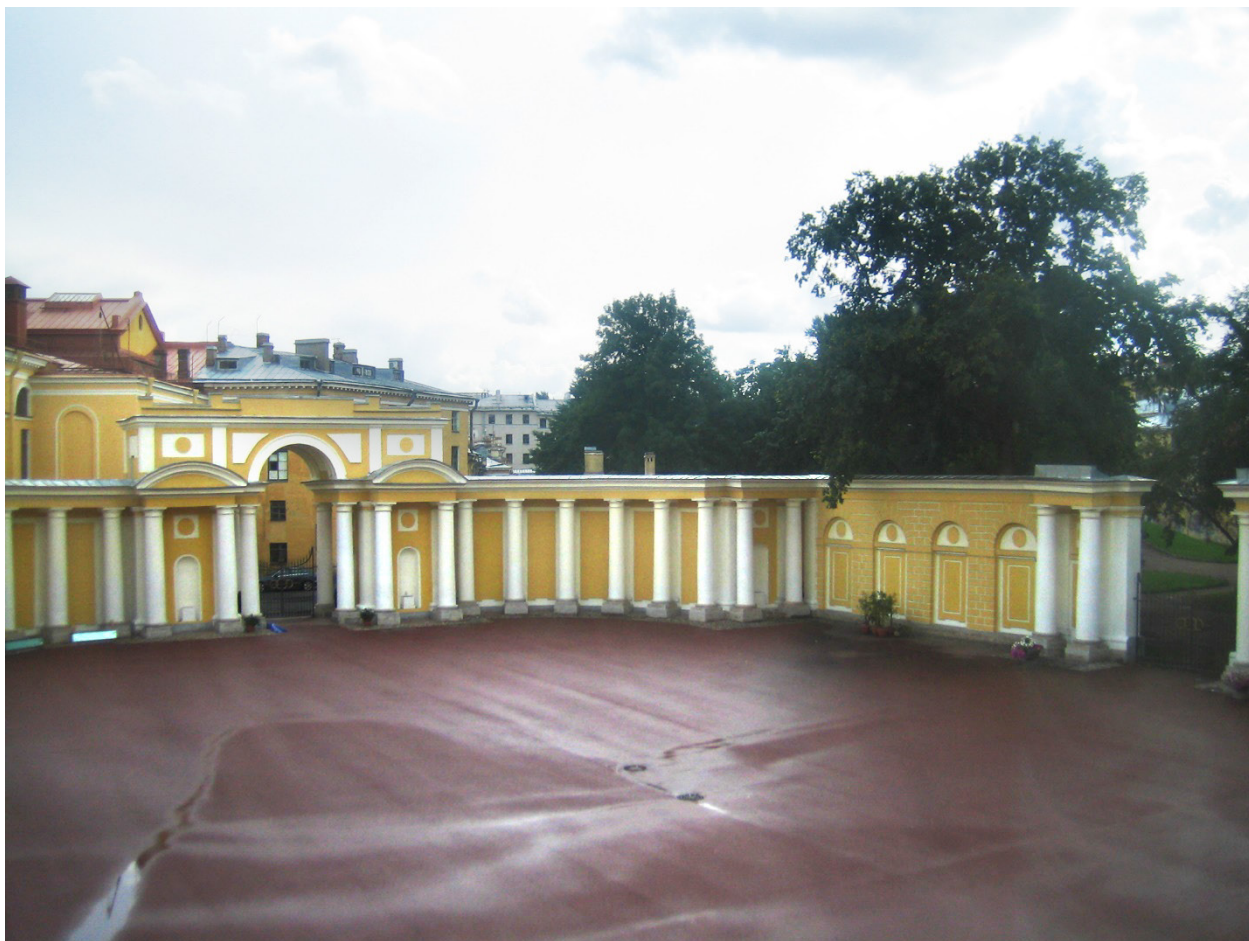
Рис. 3. Парадный двор и каменная ограда после проведения работ. 2011 г.
