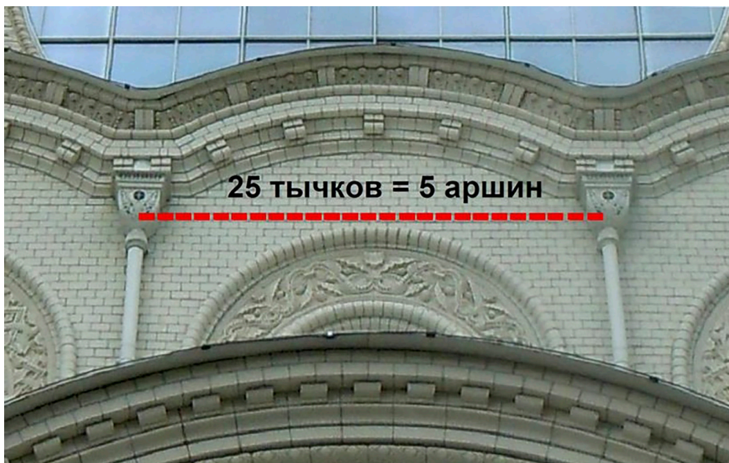
Рис. 6. Пролет декоративной арки бокового фасада содержит 25 тычков, что равно 5 аршинам
