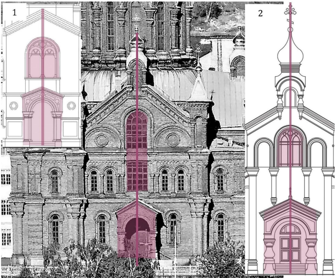
Рис. 6. Выделение центральной оси фасада большими витражными окнами и порталом с односклонным крыльцом
