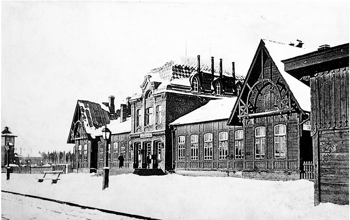
Рис. 8. Здание железнодорожного вокзала в Надеждинске (г. Серов)
