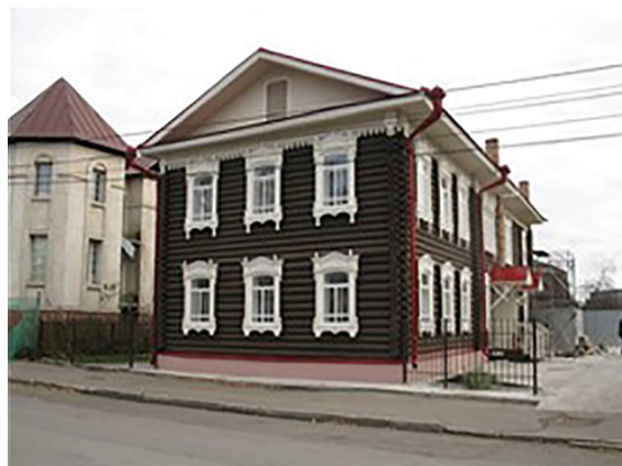
Рис. 3. Здание на ул. Пушкина, 5. Фото 2018 г., после восстановления
